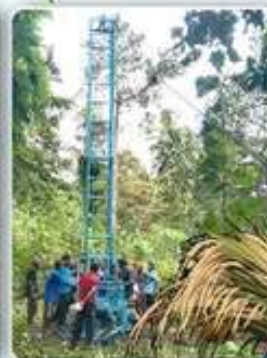
Instalasi peralatan di Desa Gamta, Papua Barat Daya
