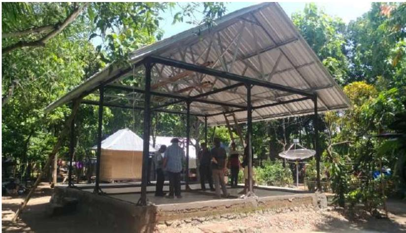
**Gambar 123 Struktur RISBA Sangat Ideal Untuk Dibangun di Atas Fondasi Lama. Dari Pengamatan di Lapangan, pada Daerah yang Mengalami Gempa, Struktur Fondasi Umumnya Tidak Mengalami Kerusakan.**
