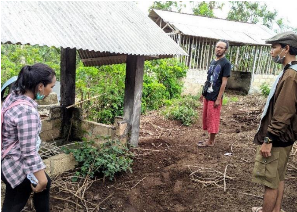
Gambar 5. 12 Kondisi kandang komunal dari program Simantri di Desa Batumadeg (Sumber: Dokumentasi Tim UGM, 2019)
