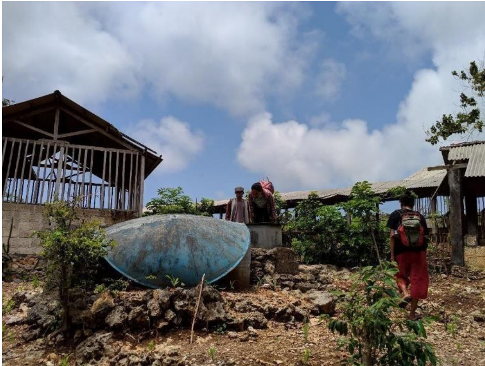
Gambar 5. 13 Digester biogas yang sudah tidak beroperasi dari program Simantri di Desa Batumadeg (Sumber: Dokumentasi Tim UGM, 2019)
