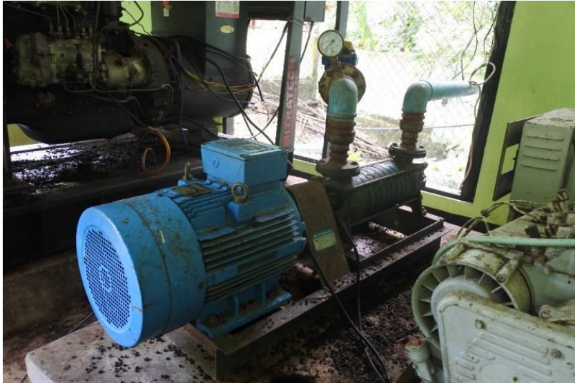
Gambar 6. 9 Generator Listrik untuk Pemompaan Air di Desa Uiasa (Sumber: Dokumentasi Tim UGM, 2019)
