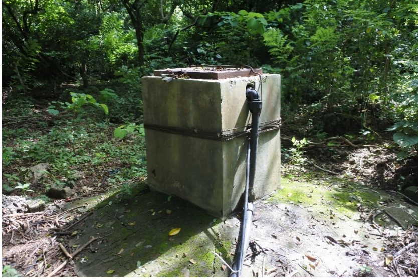
Gambar 6. 22 Sumur Bor di Dusun 2 Desa Uiasa (Sumber: Dokumentasi Tim UGM, 2019)
