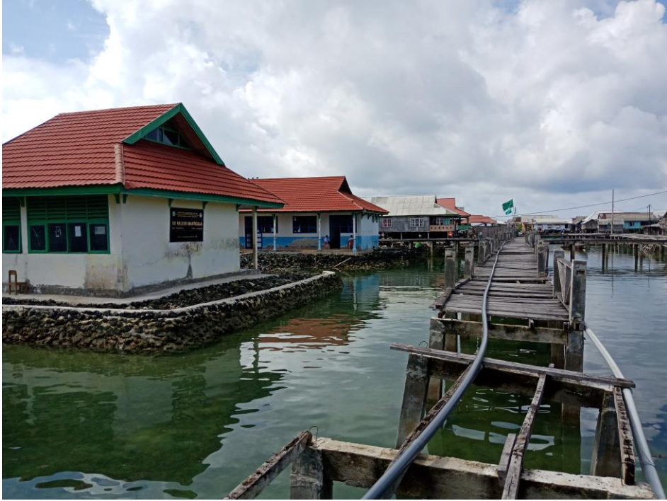
Gambar 7. 16 Pipa-pipa yang digunakan untuk mengalirkan air bersih ke Horuo laut (Sumber: Dokumentasi Tim UGM, 2019)
