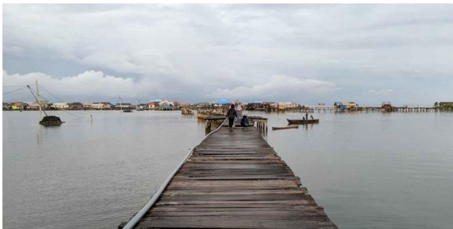
Gambar 7. 5 Jembatan penghubung desa Mantigola dengan daratan (Sumber: Dokumentasi Tim UGM, 2019)
