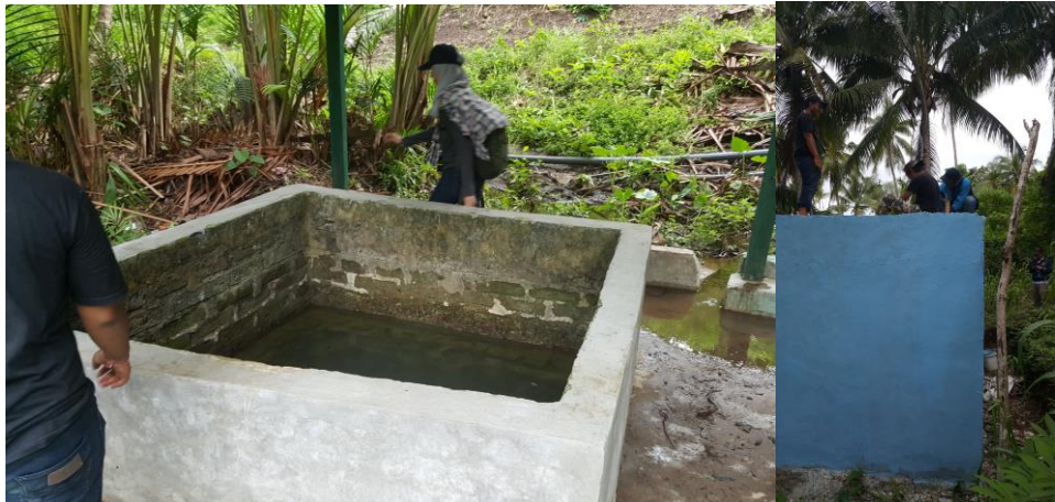
Gambar 7. 18 Sumber air (kiri) dan toren (kanan) yang sudah dibangun untuk Horuo laut (Sumber: Dokumentasi Tim UGM, 2019)
