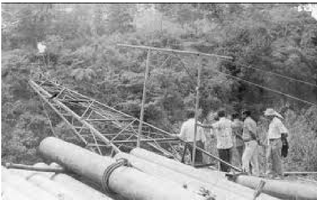
■ Proyek Air Bersih Tuk (Mata Air) Bebeng di Cangkringan (sumber: arsip.ugm.ac.id )
