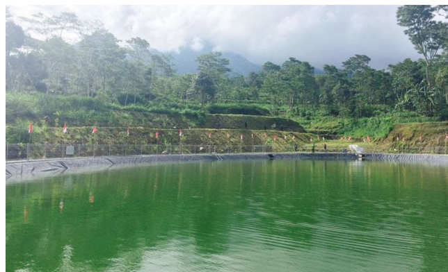
■ Embung pertama Tirtamulya dengan teknologi geomembran untuk mendukung ketersediaan air bersih di Klaten (Sumber: aqua.co.id)
