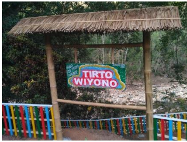
Gambar 8. Pemasangan Papan Nama Wisata
