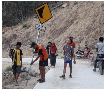
Gambar 6. Pemasangan Rambu Bencana Longsor
